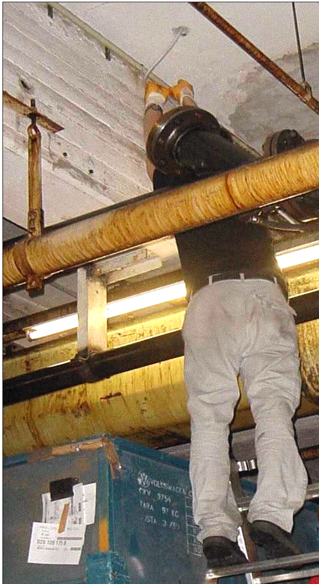
Abb. 17: Installation der Zuleitung
